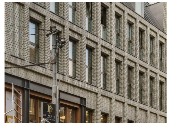
1: Het metselwerk van het Amsterdamse pand bestaat uit slanke penanten met dubbel uitkragende neggen en horizontale stroken in staand verband. Het metselwerk krijgt daardoor diepte en een dynamische schaduwwerking.
